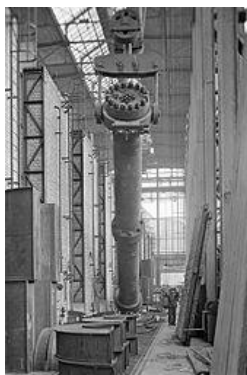
Abb. 99: Links der erste Reaktor im Ammoniak-Werk Oppau 1913, rechts die Entwicklung der Ammoniakproduktion von 1946 bis 2007
