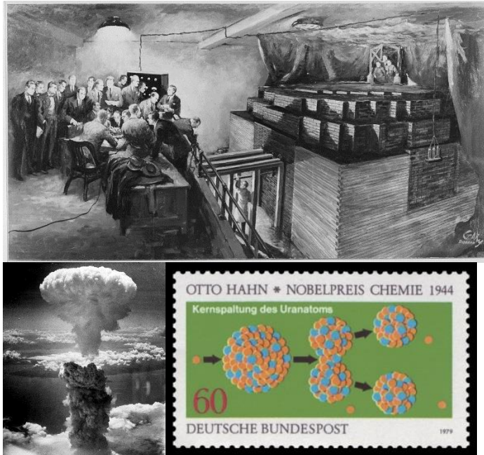
Abb. 89: Oben Skizze von Gary Sheehan, Atomic Energy Commission , vom Moment der Inbetriebnahme des ersten Kernreaktor: 2.12.1942 um 15.22 Uhr Ortszeit: Forscher um Fermi überwachen den CP-1-Reaktor, während er beginnt, von selbst weiterzulaufen (Beginn der Kernreaktion), weil Physiker Weil (unten) langsam die Bremsstange herauszieht. Links unten die Explosion über Nagasaki, 9. August 1945 nach dem Atombombenabwurf. Der Atompilz stieg 18 km hoch, Rechts unten: Briefmarken der Deutschen Bundespost, 1964 und 1979, zum Gedenken an die Entdeckung der Kernspaltung
