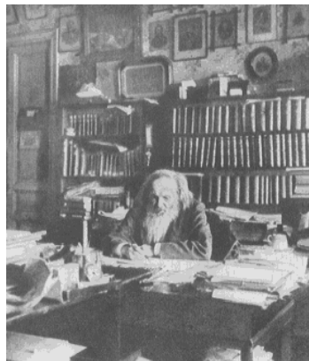
Abb. 67: Mendelejew in seinem Arbeitszimmer
