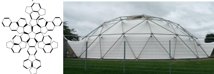
Abb. 103: Links das Netzwerk des „aufgeklappten“ C 60 -Moleküls. Das Molekül besteht aus 12 Fünfecken und 20 Sechsecken, die ein abgestumpftes Ikosaeder ergeben. Es wird daher auch als Fußballmolekül ( footballen ) bezeichnet. Rechts: Die Geodätische Kuppel von R. Buckminster Fuller (Detroit 1978, im Jahr 2000 in Weil am Rhein aufgestellt), nach dem das Molekül benannt wurde.
